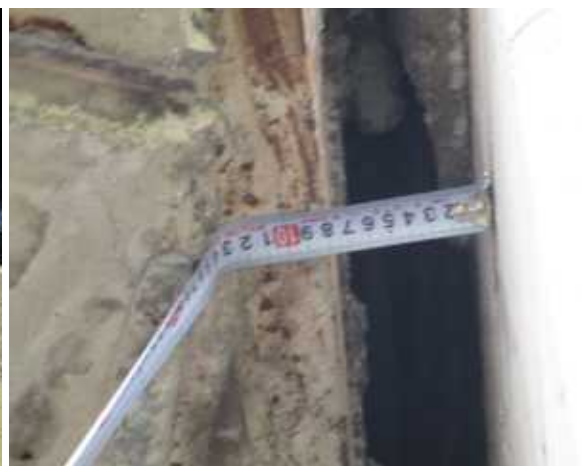
신축이음 유간거리 측정
