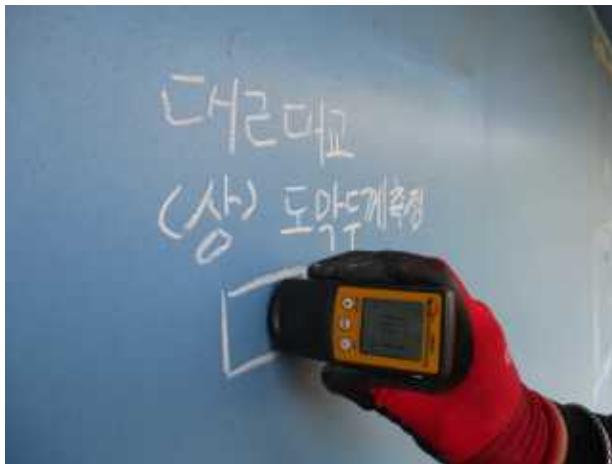
거더 외부 도막두께 측정
