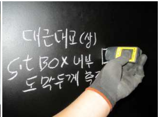
거더 내부 도막두께 측정
