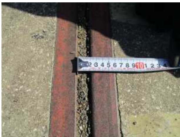
신축이음 유간거리 측정
