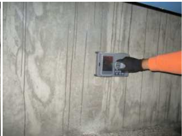
철근 피복두께 측정
